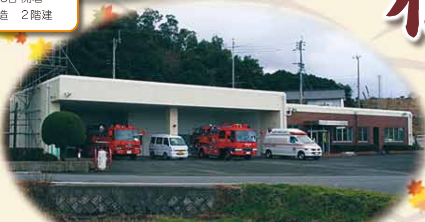
中央消防署 苓北分署 (天草郡苓北町志岐1231) 昭和56年2月28日 開署 鉄筋コンクリート造 平屋建
