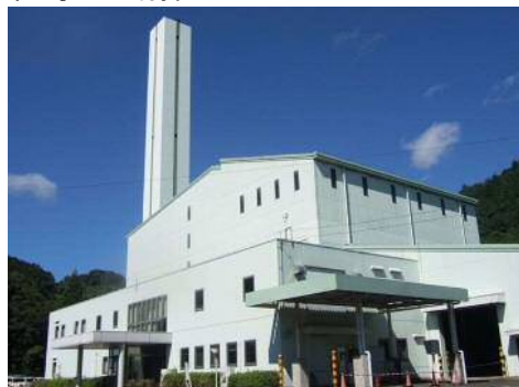
松島地区清掃センター
